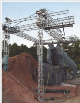
Hélictreillage et soutien d'une statue d'éléphant
